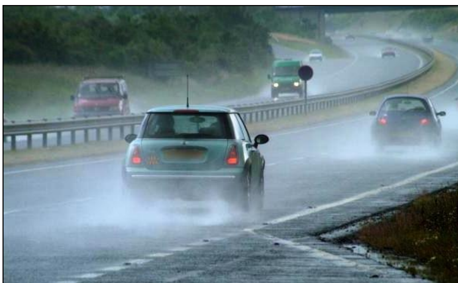
Figura 107 –Asfalto non drenante
